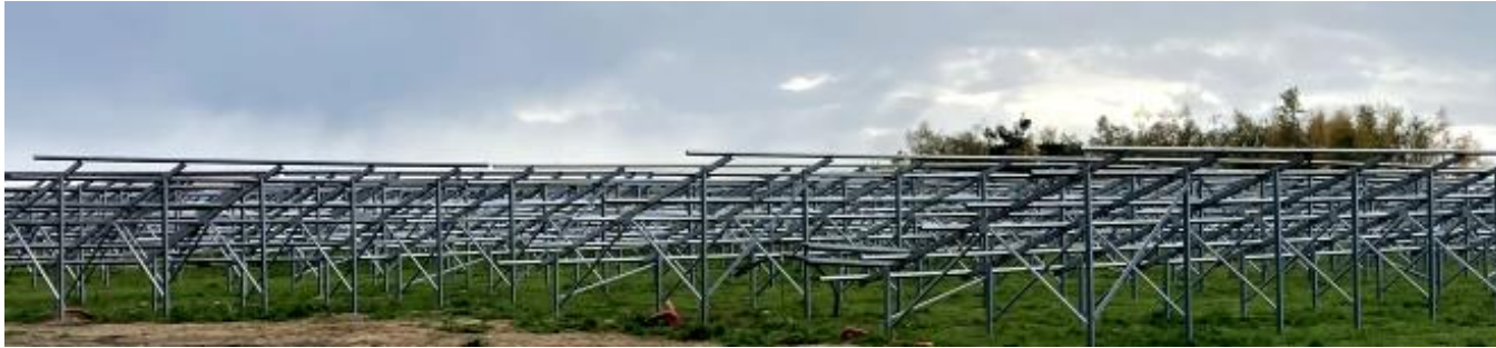
Photo 5 : Exemple d'installation des pieux en maintenant la couverture végétale au sol
